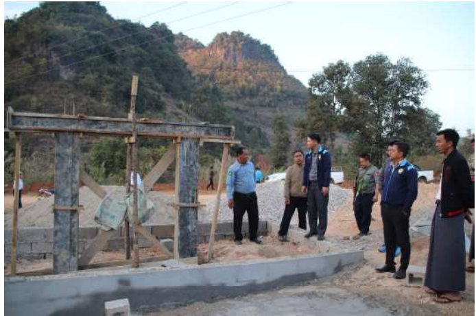
ကိုးကန့်ကိုယ်ပိုင်အုပ်ချုပ်ခွင့်ရဒေသဦးစီးအဖွဲ့ ဥက္ကဋ္ဌ ဦးကျောက်တယ်ချန်က လောက်ကိုင်မြို့အဝင်ဆိုင်းဘုတ် ဆောင်ရွက်နေမှု လုပ်ငန်းအား ကွင်းဆင်းကြည့်ရှုစစ်ဆေးနေစဉ်
