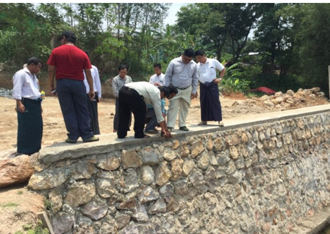
ဟိုပန်မြို့နယ် မဲဆန္ဒနယ်အမှတ်(၂) ဦးရန်ကျော်က နမ့်ဆောင်ချောင်း မြေထိန်းနံရံ တည်ဆောက်ပြီးစီးမှု ကွင်းဆင်းကြည့်ရှုစဉ်
